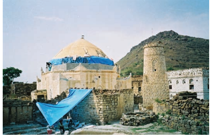
١- قبة الزوم قبل أعمال الترميم
