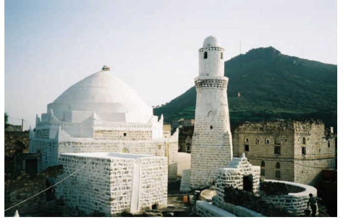
٣- بعد ترميم القبة واستكمال المنارة
